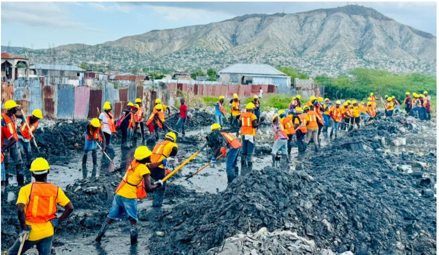
Travaux de curage aux Gonaïves, les travailleurs en action
